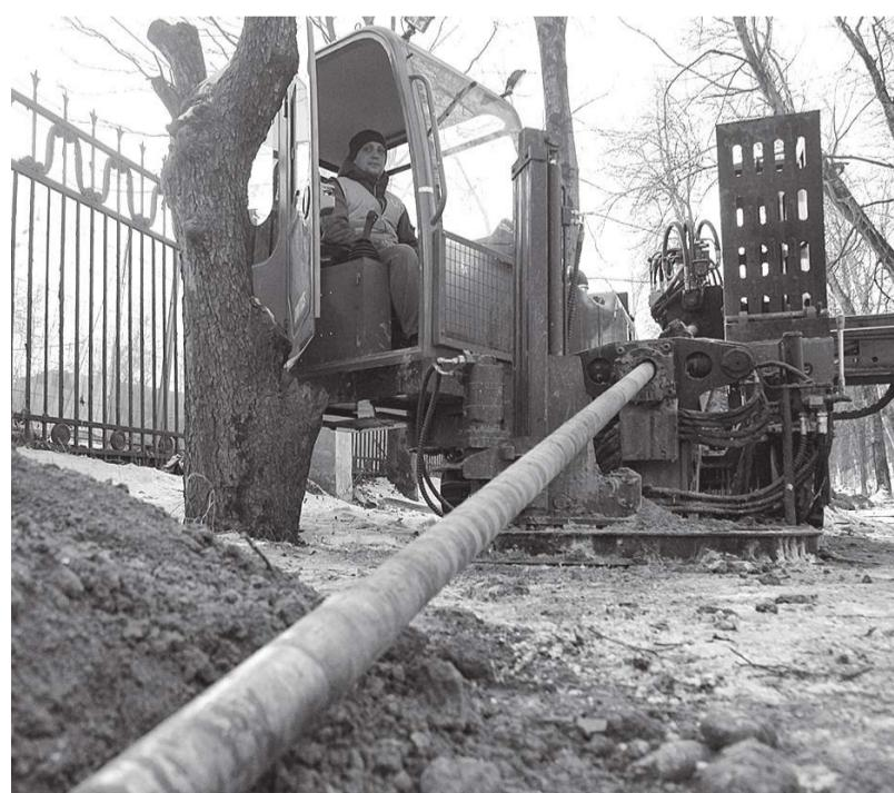
В парке «Швейцария» в рамках работ по благоустройству на три четверти выполнена прокладка кольцевого водопровода. Для прокладки используется бестраншный метод горизонтально-направленного бурения.
