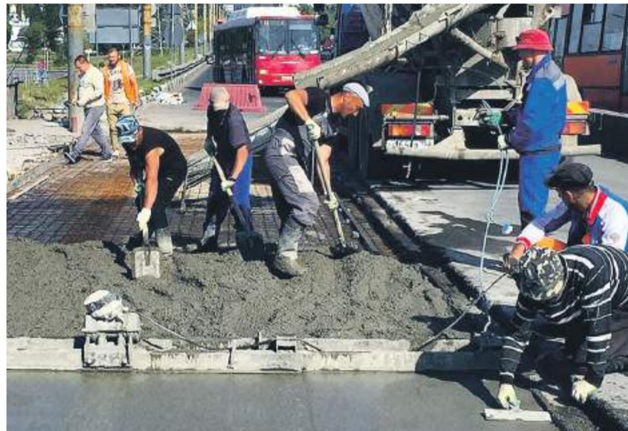
— Работы идут по графику, отставания нет, — рассказали специалисты управления. — Ремонт на последней полосе мостовой переправы движется к концу, уже закончено строительство железобетонной распределительной плиты.
